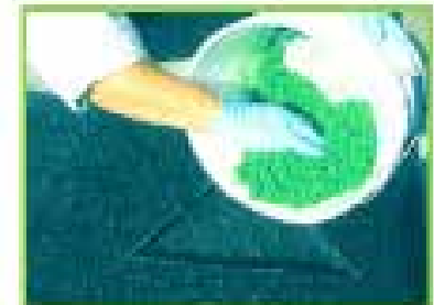
Pour mixed granules into the area
